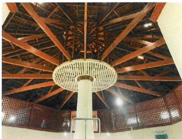
Fig. 38 – Imagem da estrutura de treliça de madeira do telhado. Fonte: INEPAC
