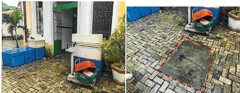
Fig. 32 – Imagem da entrada de serviço do mercado. Fonte: INEPAC
