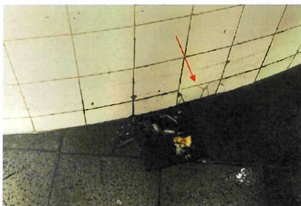
Fig. 40 – Imagem de um dos ratos do interior do balcão de peixes e trinca nos azulejos. Fonte: INEPAC
