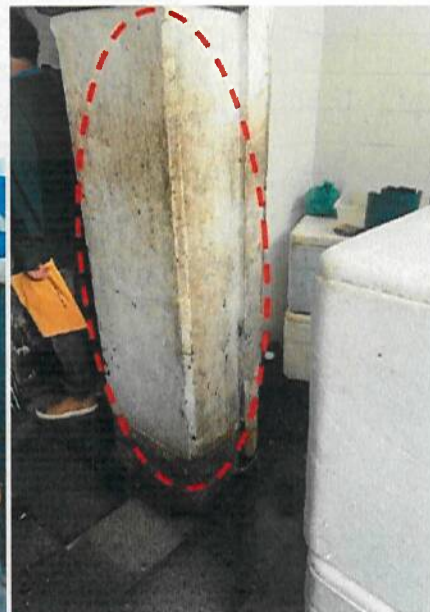
Fig. 36 e 37 – Imagens das paredes da entrada de serviço. Nota-se deterioradas devido ao posicionamento dos isopores e caixas de armazenamento na frente da parede. Fonte: INEPAC
