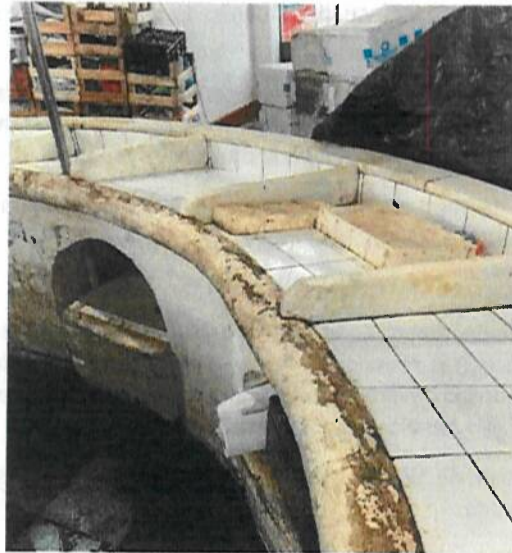
Figura 3 – Situação atual das bancadas
