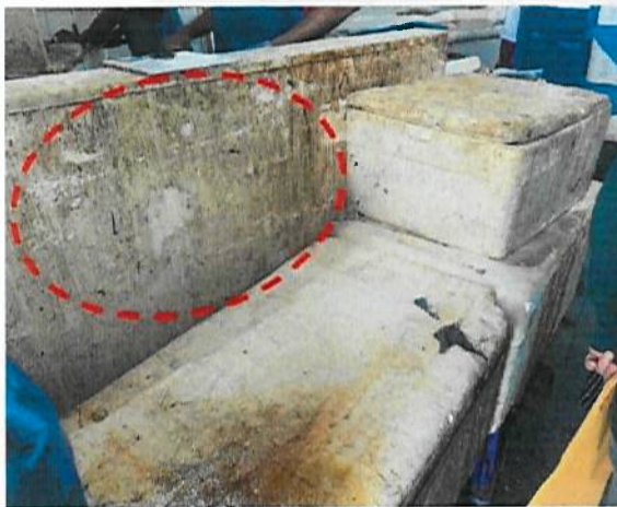
Fig. 36 e 37 – Imagens das paredes da entrada de serviço. Nota-se deterioradas devido ao posicionamento dos isopores e caixas de armazenamento na frente da parede. Fonte: INEPAC
