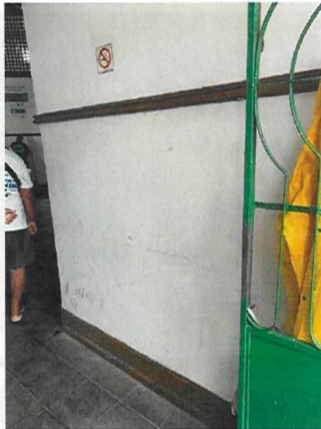
Fig. 35 – Imagem da parede da entrada de serviço. Fonte: INEPAC
